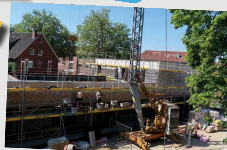
Baufortschritt für das neue Gemeindezentrum an der Elisabethkirche
